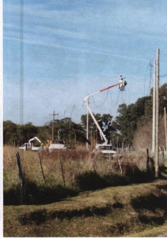
Se realizo a nuevo, se cambio poste por columna de 11/750 el puesto de transformación N° 2021 en Benquerencia.
