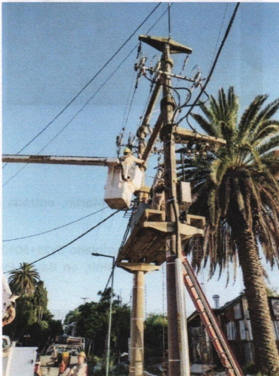
Se cambio transformador por ampliación de potencia de 50 kva a 100 kva puesto N°793 Barrio Chacras Del Monte II.
