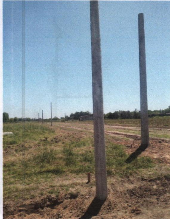
Se realizó nueva plataforma con columnas de 11/750 para instalar reguladores de tensión en el alimentador N° 3 hacia Benquerencia sobre ruta N° 41
