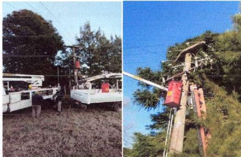
Se desarmo línea de MT que alimentaba el puesto N°481, se sacaron 1000 metros de cable 1x25, columnas de hierro, de hormigón y transformador de 100 Kva.
