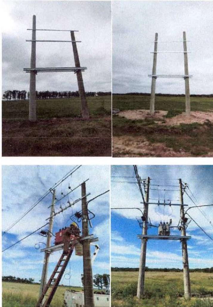
Se realizo nuevo puesto de transformación trifásico de 16 Kva y conexión T2-BT para abonado ABSA en calle Unión e/ Alberti y Córdoba.
