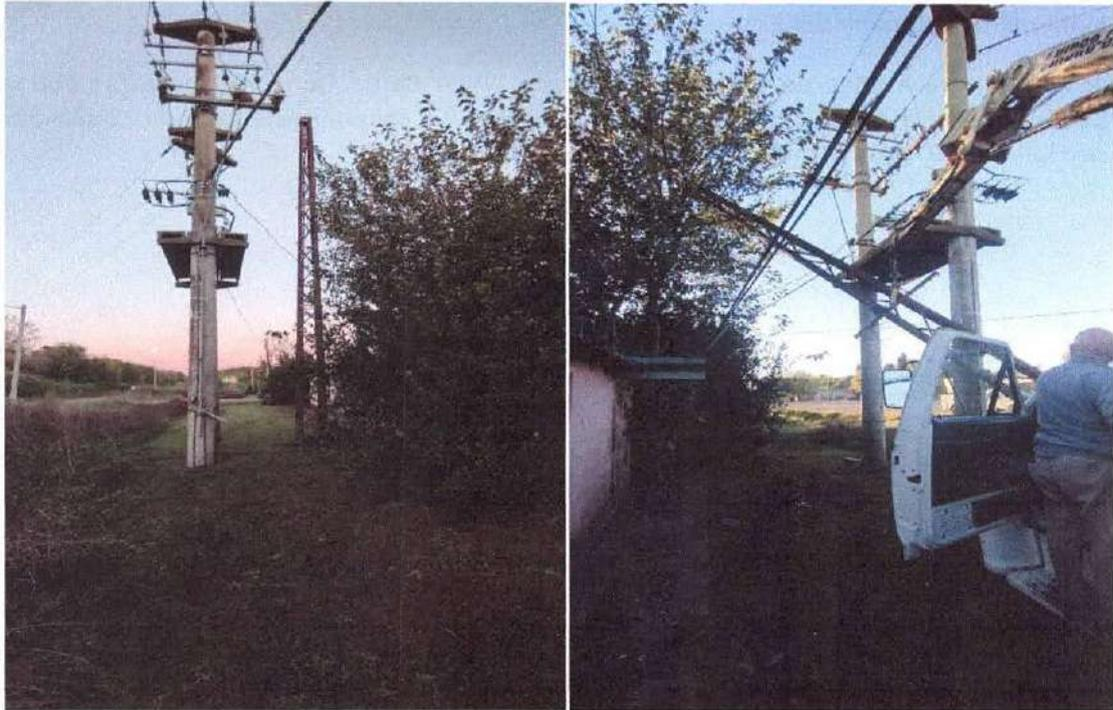
Se repararon cables de MT cortados por maquina de la empresa SACDE en Ruta N°3 Km 125, 100 metros de cable 50/8, columna retención de 9.50/2400, pernos y aisladores de MT.
