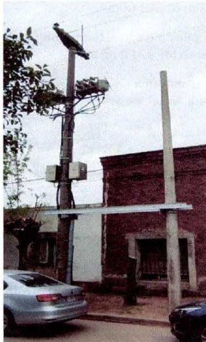
Se realizó ampliación de potencia de 40kva a 63kva el puesto N°78 (Trifásico), se reemplazó 500 metros de cable 2x50 por 3x35+50+25 preensamblado. En zona de 5 Montes sobre calle Lapacho.
