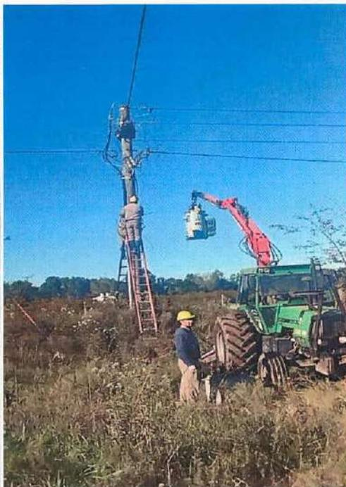
Se cambio transformador por ampliación de potencia de 25kva a 40kva calle Unión y B M Petra De San José. Puesto N°159.
