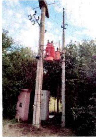
Se realizo obra de ampliación de potencia de 5 kva a 10 kva monofásico, para abonado Delger Gonzalo (11042) en zona rural de Videla Dorna. Puesto N°611
