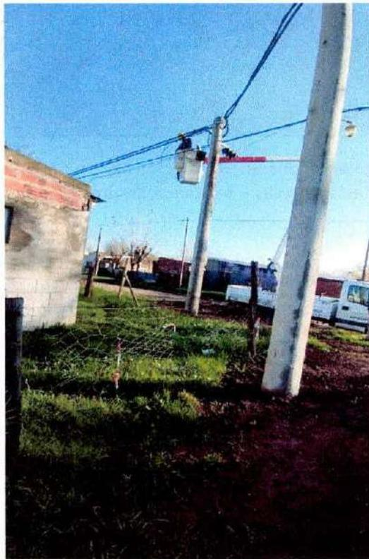
Se realizo mantenimiento en el puesto de transformación N°566 B° San José, se cambiaron seccionadores de BT y cables de salida del transformador.
