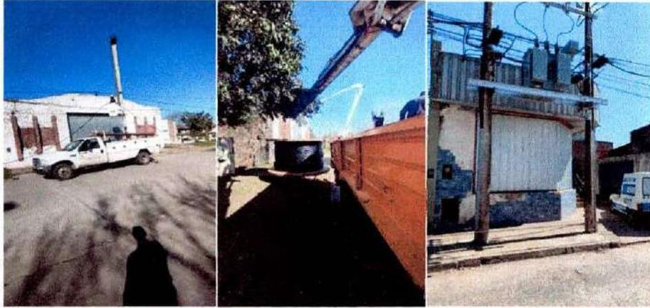
Se realizaron 2 nuevas líneas de preensamblado con cable 3x95+50+25 (200 metros) y modificaciones de BT en Abbott para habilitación del nuevo puesto de 100 Kva para zona del Barrio Tanque De Agua y se desarmo puesto de 63 Kva existente.
