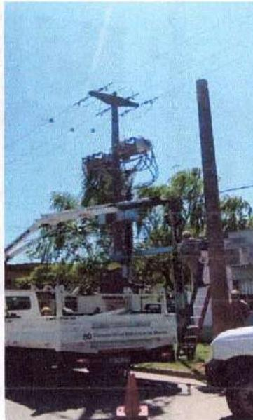
Se realizaron 4 bases de hormigón con columnas de 7.50/2800 para realizar línea de preensamblado en barrio Eva Perón sobre calle R Mouras E/ Recalde y J Cosma. Y sobre calle O Morresi e/ H Emiliozzi y J Cosma.
