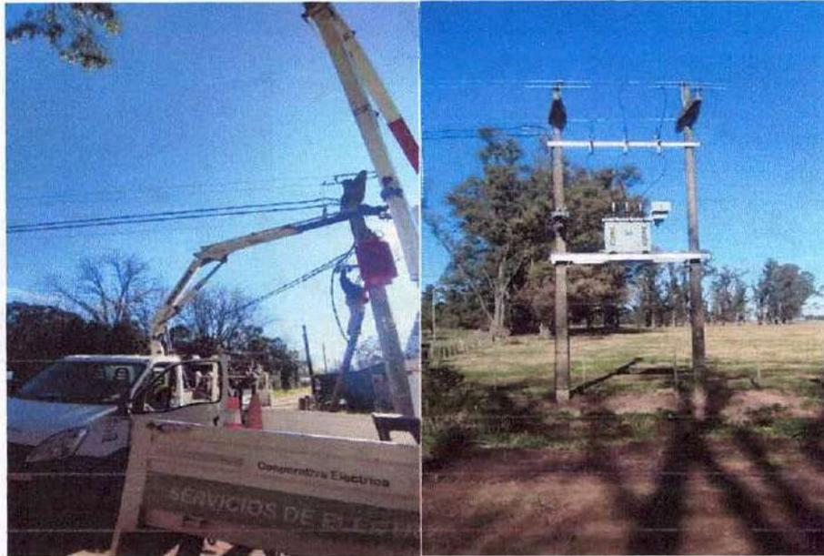
Se cambiaron seccionadores APR de BT en los puestos de transformación N°478, (B° Los Claveles), Puesto N° 544 (B° Coppola), Puesto N° 535 (VAL).
