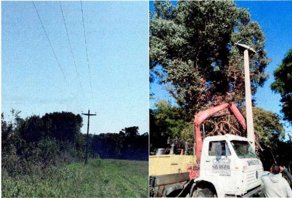
Obra para abonado Lácteos Rondo S.A se realizo plataforma y ampliación de puesto de transformación de 50kva a 100kva en zona rural de Ruta N°41 bajada a F A. Berra.
