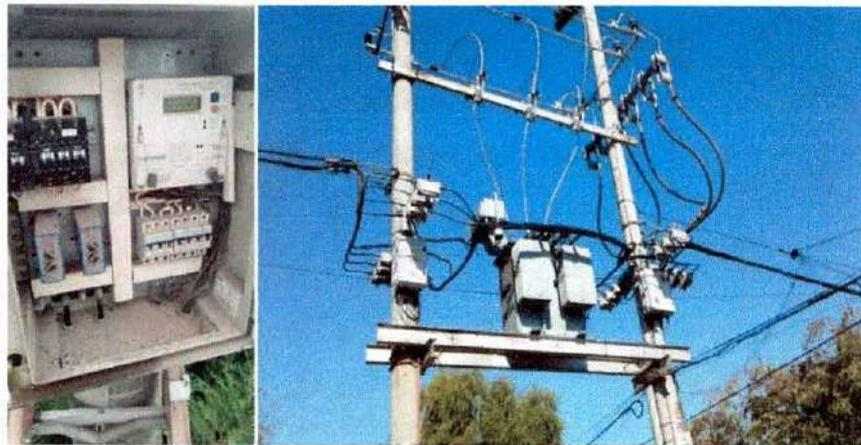
Se procedió al recambio de medidores monofásicos electrónicos año 2000 que se encuentran partidos y otra tanda de medidores con lectura Activa sola. Se está utilizando medidores con lecturas activas y reactivas, ya que medidores electromecánicos queda solamente 1.
