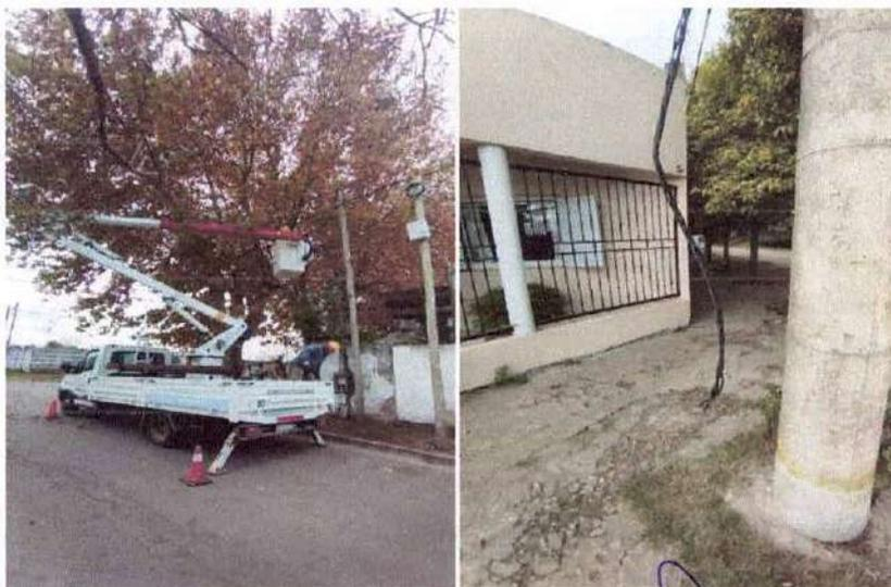
Se realizo mantenimiento del puesto de transformación N°15 Ab. Santa Rita Del Monte S.A, se cambio cruceta y descargadores de MT alimentador N°3, sobre ruta N°41
